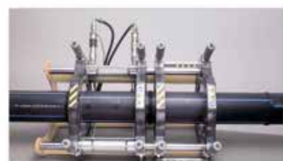
Fase 5: soldadura con elementos en presión
