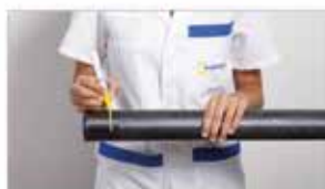
Marquer la profondeur d'insertion.
