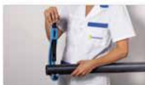
Coupez le tuyau avec le coupe-tube.
