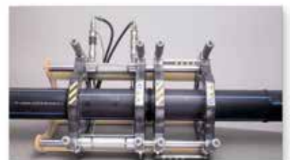
Fase 5: Saldatura con gli elementi in pressione.
