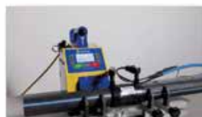
Iniciar la soldadura. Realizar los controles necesarios (alineación, profundidad de inserción e indicadores de fusión).
