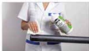
Limpiar las superficies con el detergente idóneo.
